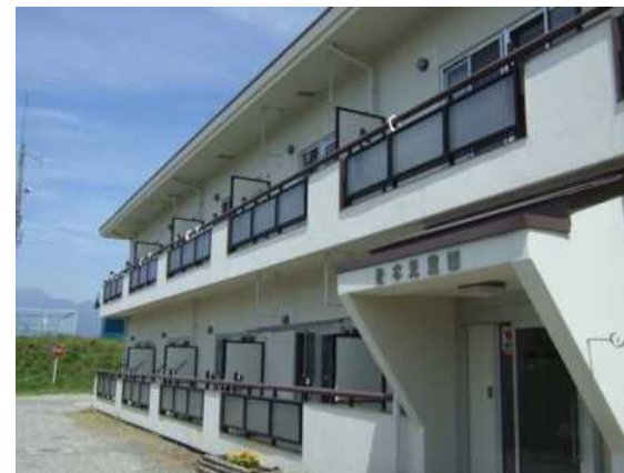
↑ 老朽化していたサッシを取り 替えるなどし、外観も新しく なりました。
