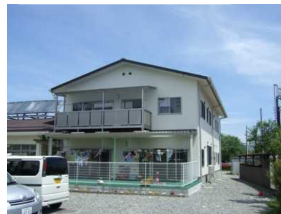
↑ 新たに建てられたショートステイ 棟。1 階は新しい幼児寮、2 階は ショートステイ用の居室。
